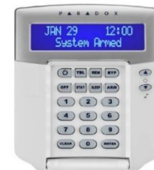
Bezvadu signalizācijas sistēma ar kustību sensoriem katrā istabā un dūmu detektoriem (pieslēgti pie apsardzes pults); panelis PARADOX (Kanāda)
